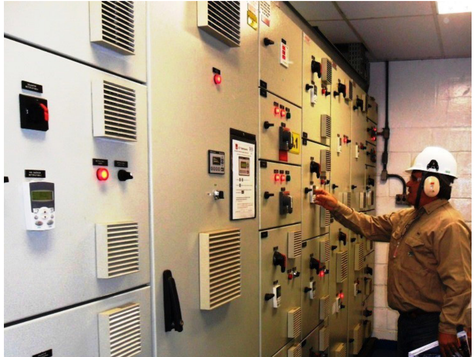
Figura 10- Instalação elétrica de baixa tensão “segregada”
