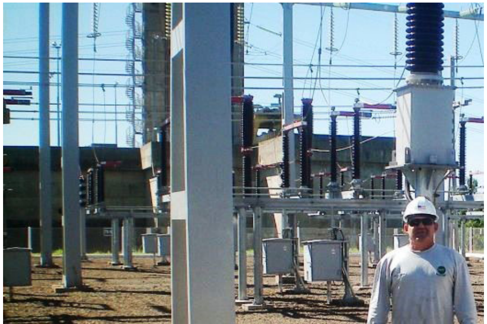
Figura 9- Instalação elétrica alta tensão sem segregação
